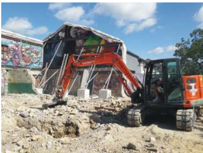
Les nouvelles fondations sont sorties de terre
